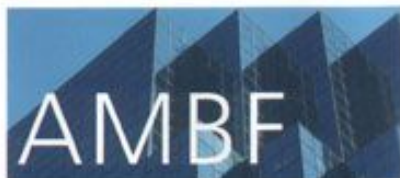
Линейная геометрическая текстура этого архитектурного фасада подчеркивается твердым характером шрифта сан сериф.
