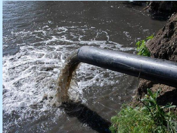
Канализационные стоки с. Стройкерамика в р. Падовка
