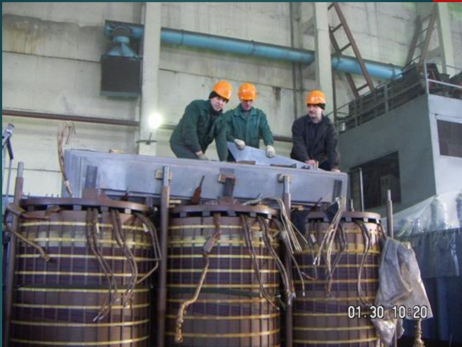
Разборка магнитопровода силового трансформатора
