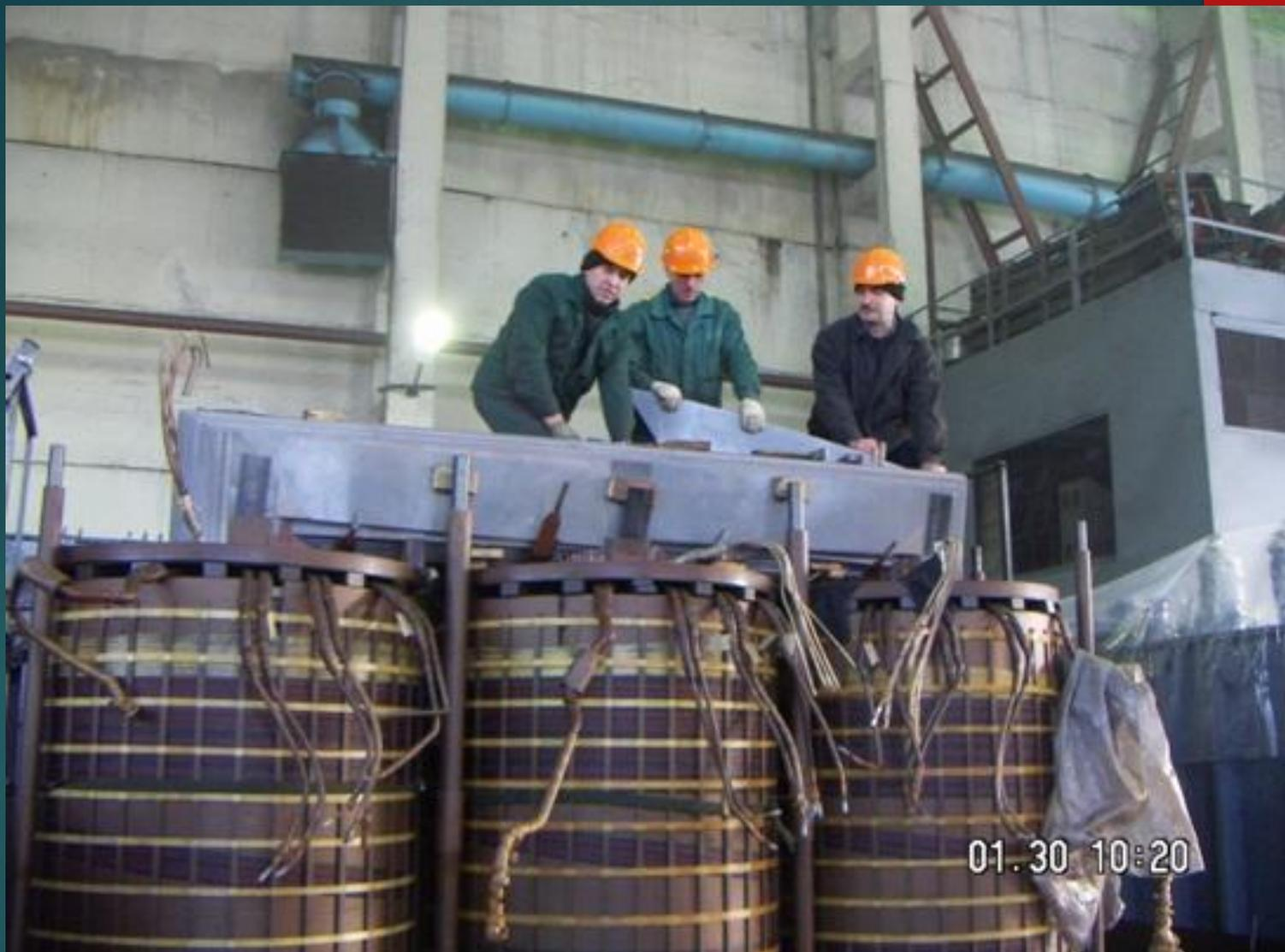
**Разборка магнитопровода силового трансформатора**
