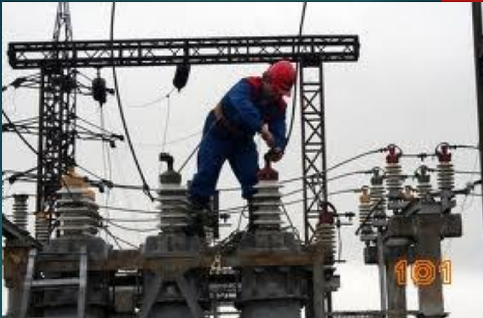
**Очистка изоляторов силового трансформатора при текущем ремонте**
