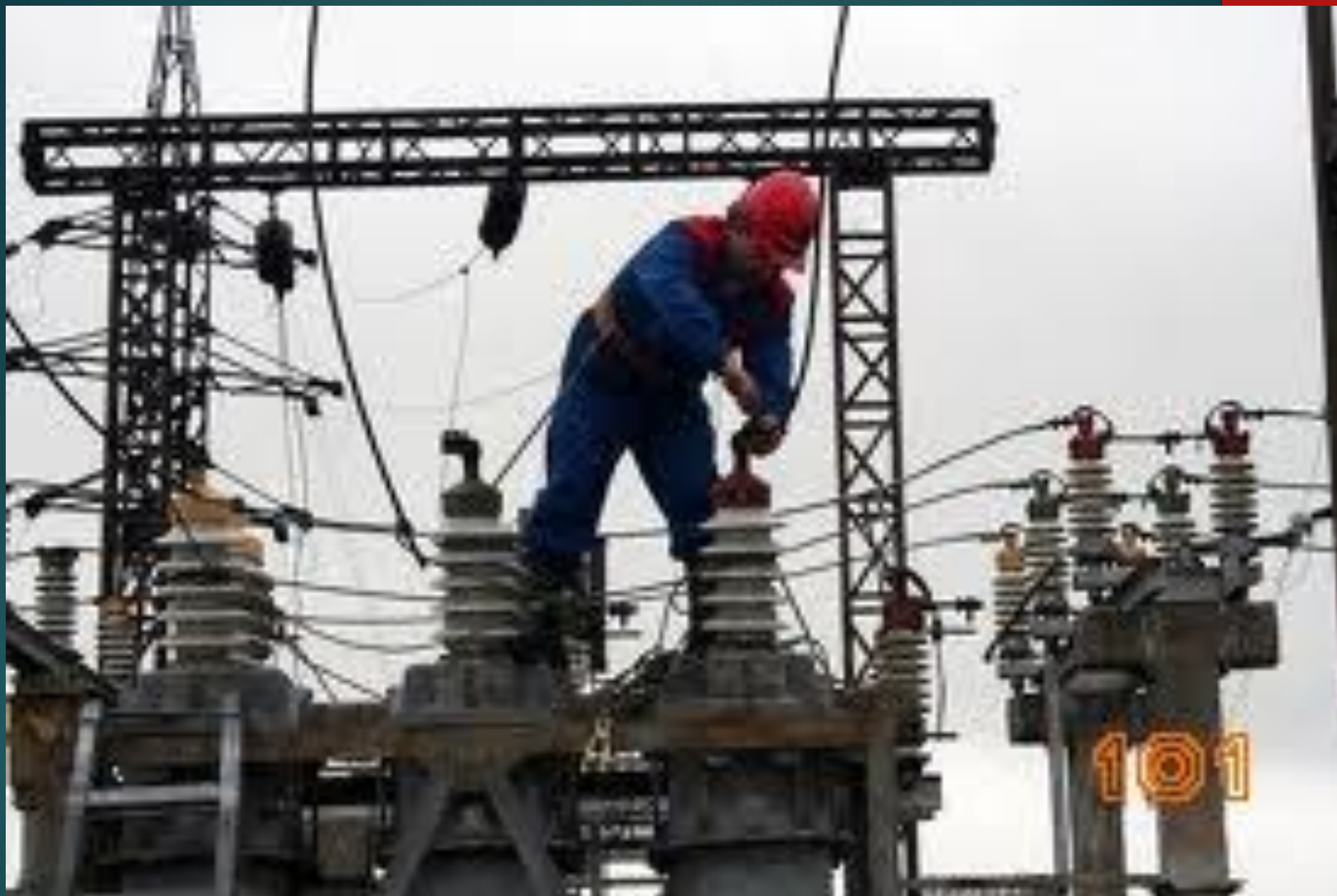
Очистка изоляторов силового трансформатора при текущем ремонте
