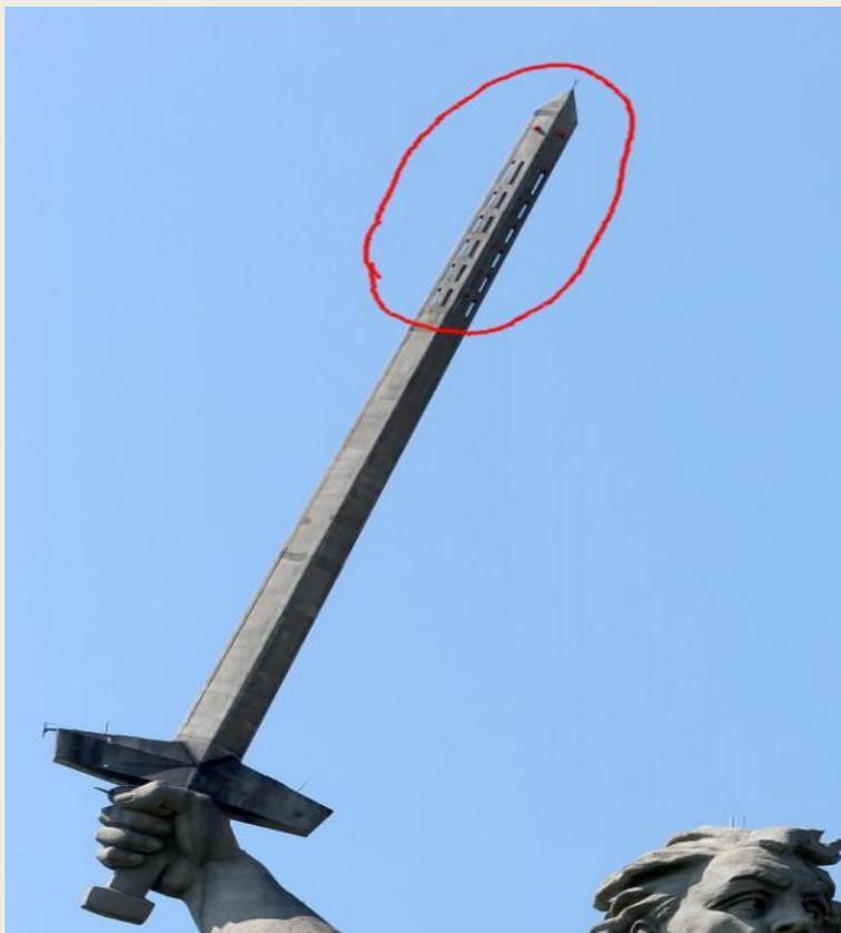
Меч шумил очень сильно из-за того, что оторванные титановые пластины хлопали на ветру по каркасу из нержавеющей стали
