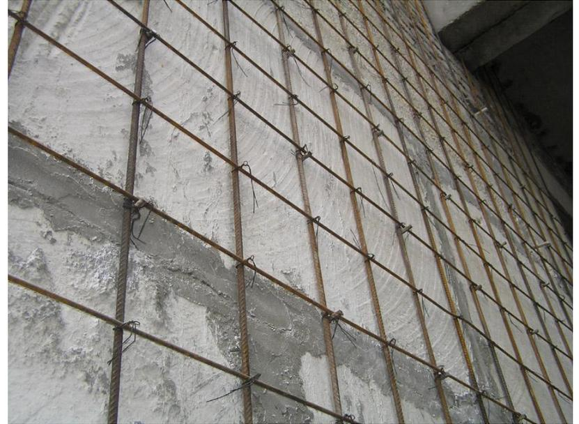
Между сеткой и стеной необходимо обеспечить зазор 5-10 мм в зависимости от толщины слоя штукатурного раствора.
