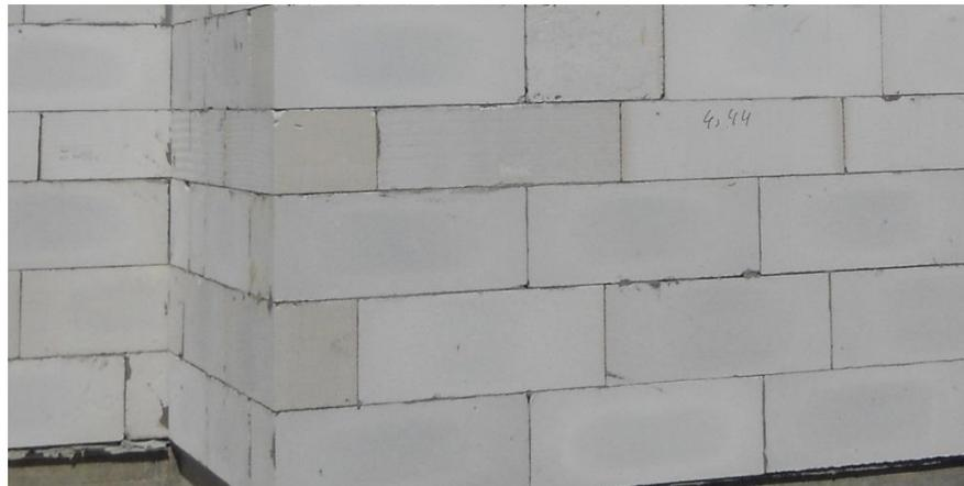
Увлажнить до насыщения или обработать грунтовочным составом ГС 1.
