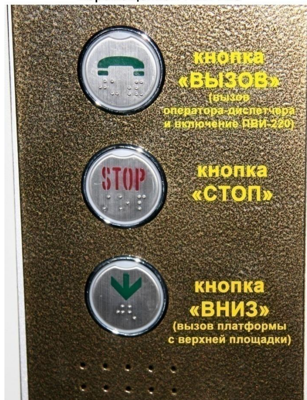
Кнопочный пост управления на посадочной площадке
