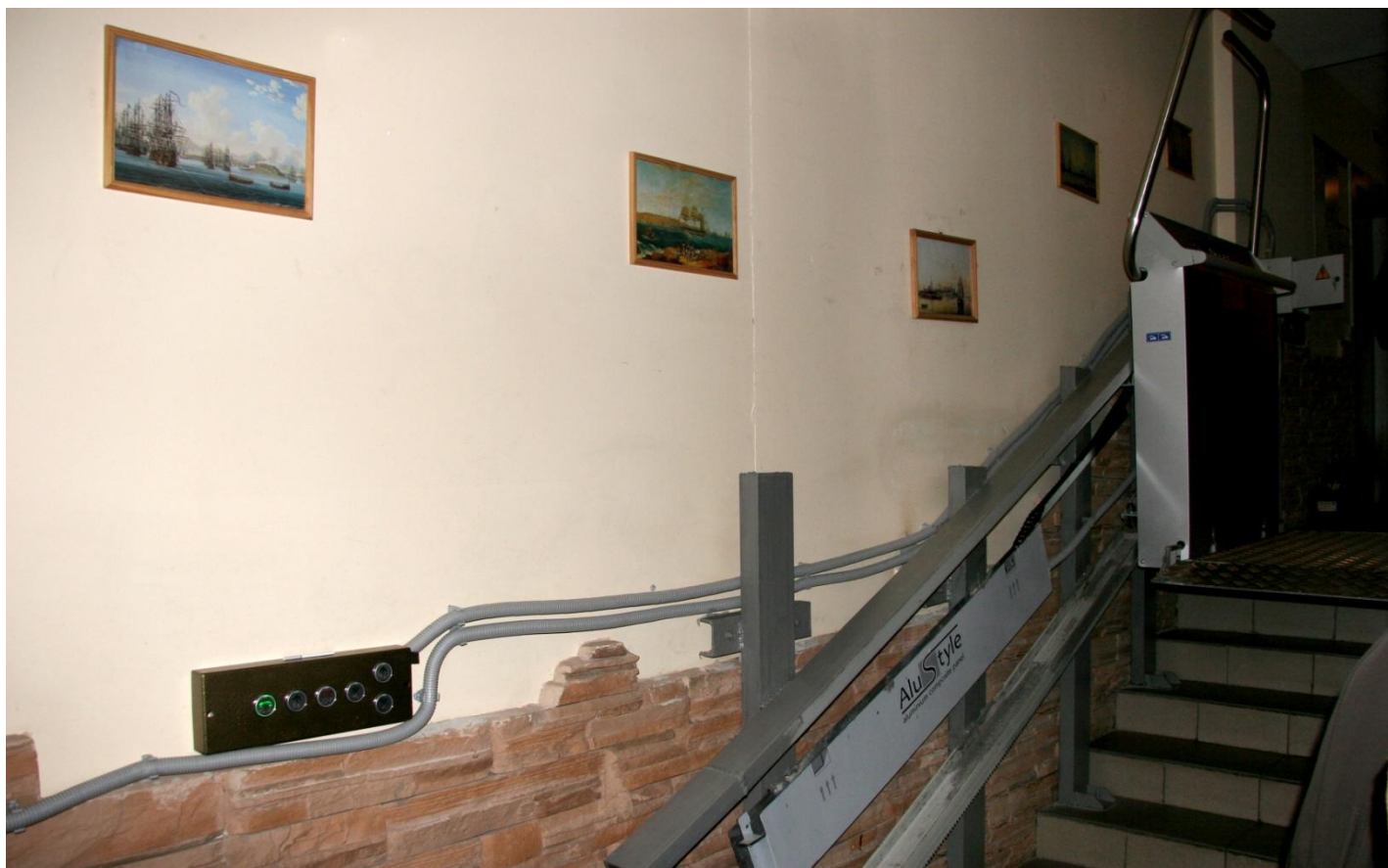
Пульт управления и направляющие платформы подъемной для инвалидов ПНИ-200
