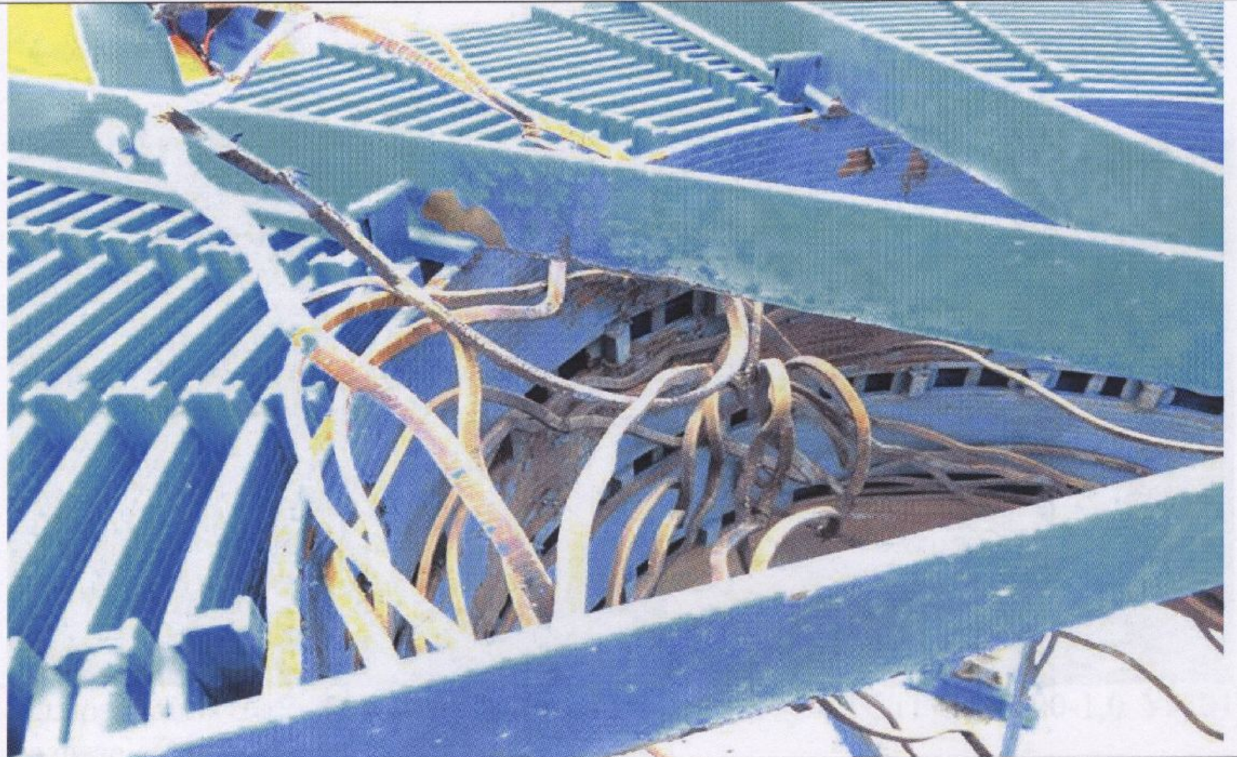
Иллюстрация №3. Токоограничивающий реактор РТСТГ-35-1600-1,0 УХЛ1 на фазе «А».
