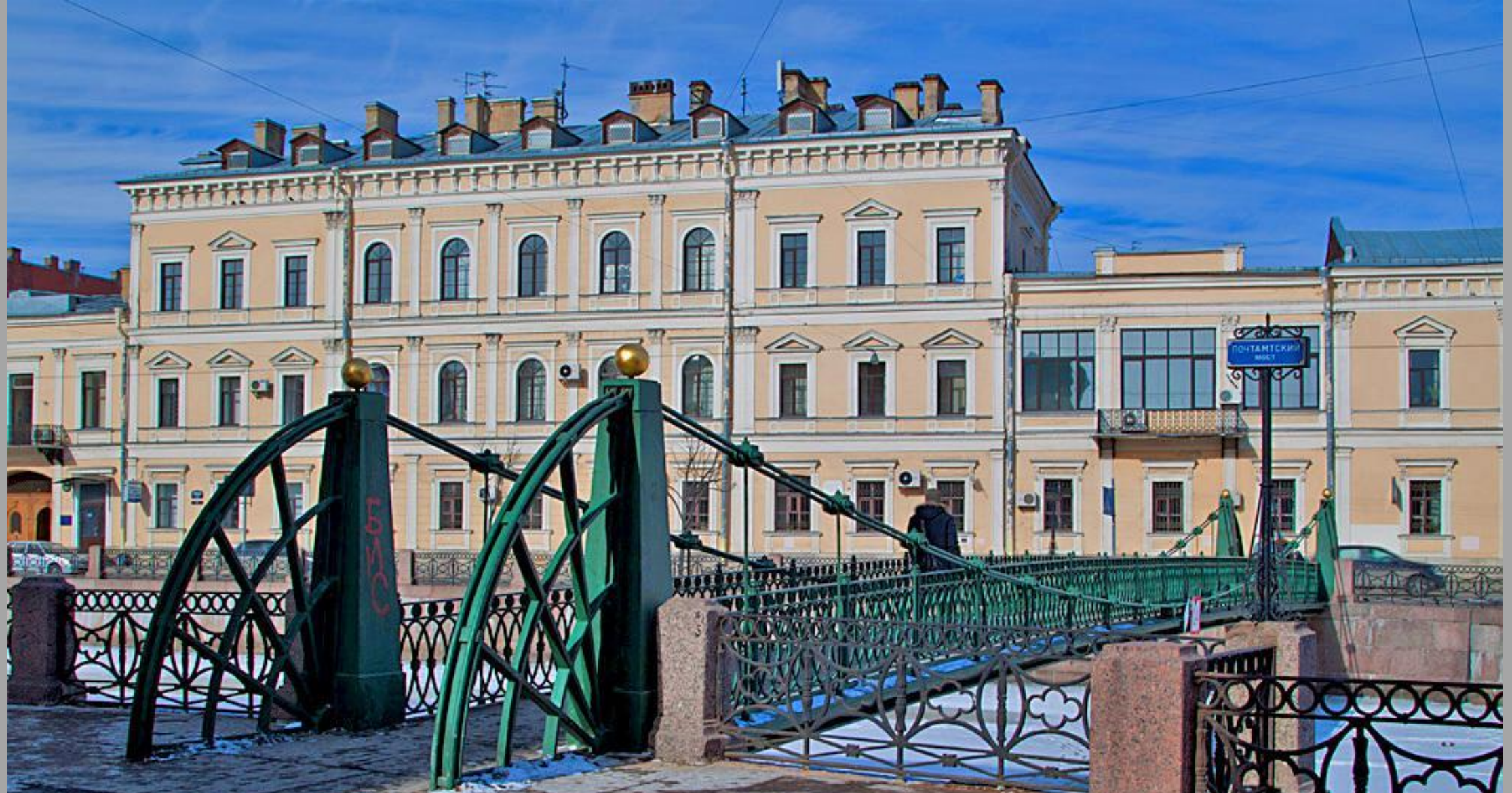
Почтамтский мост (Малый Цепной, Прачечный) — пешеходный висячий мост через реку Мойку в Адмиралтейском районе Санкт- Петербурга, соединяющий Казанский и 2-й Адмиралтейский
