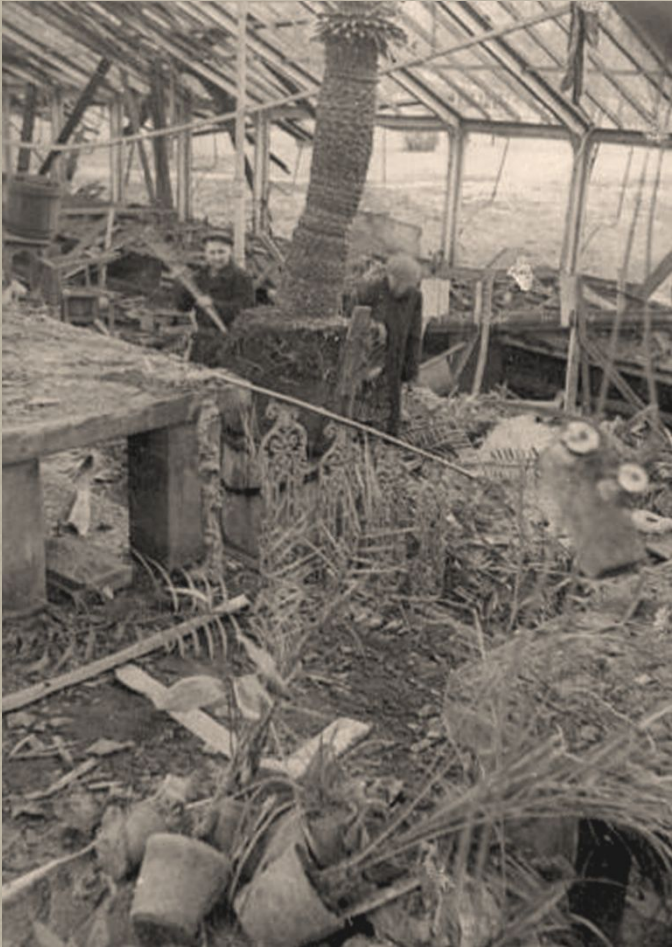
15 ноября 1941 года. Разрушенная оранжерея Ботанического сада.
