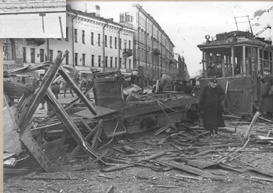
Трамвай, разрушенный прямым попаданием фугасной бомбы на площади Нахимсона (Владимирская пл.).
