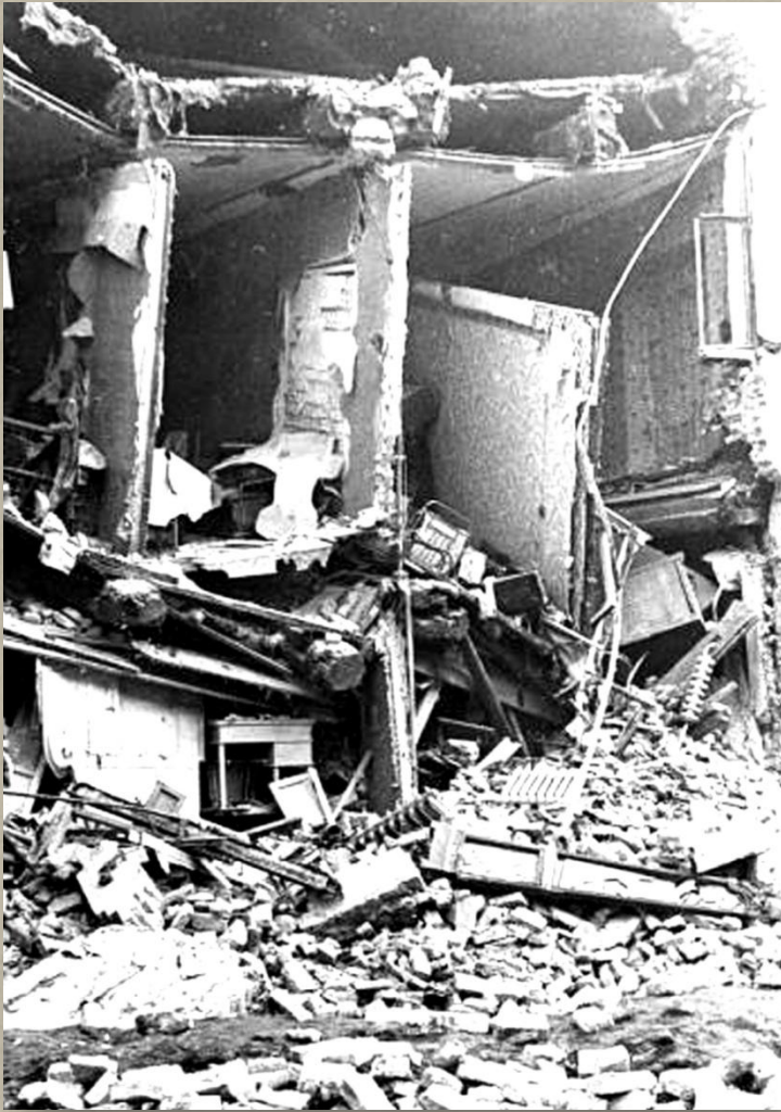
Разрушения во дворе дома на набережной Фонтанки . Фотограф Мазелев Р. А.
