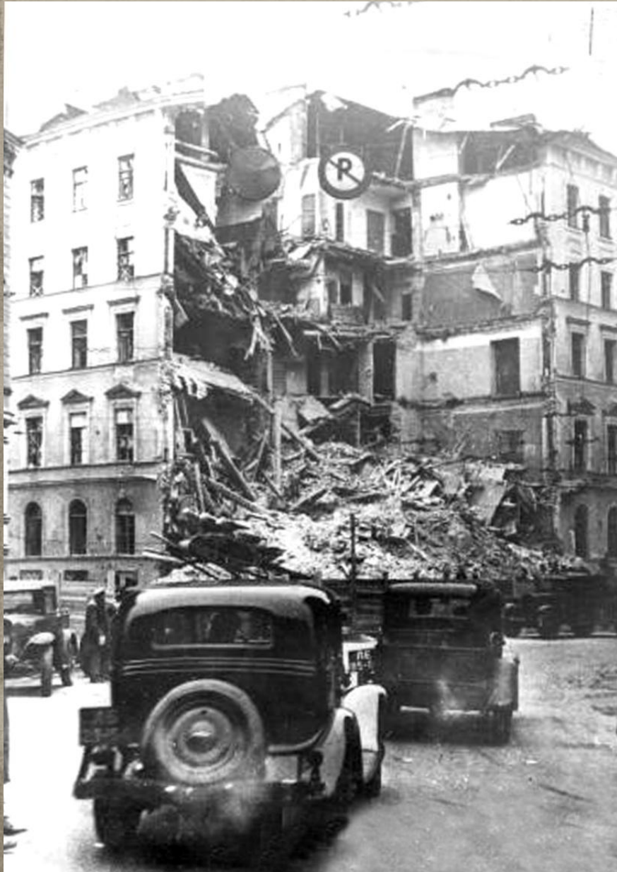
Дом на углу улицы Гоголя и Кирпичного переуллка, разрушенный авиабомбой. Фотограф Коновалов Г.Ф.
