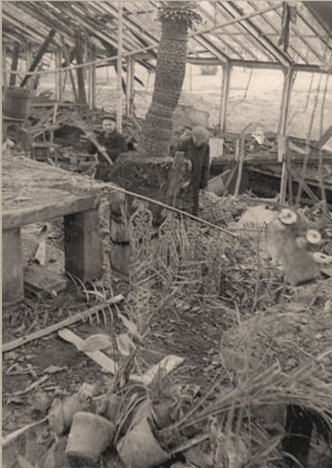
15 ноября 1941 года. Разрушенная оранжерея Ботанического сада.
