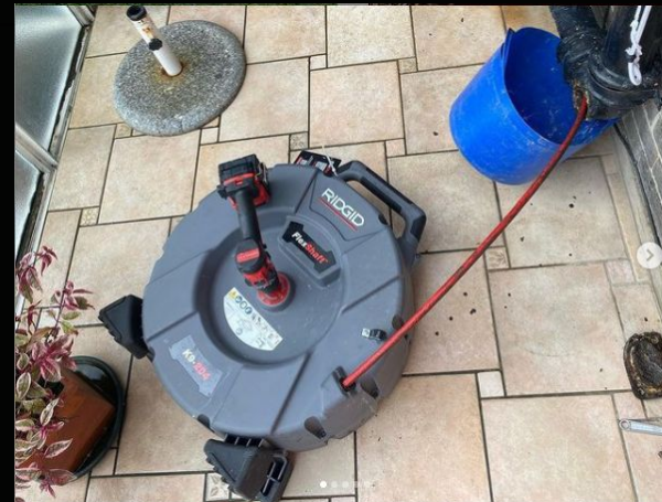
Прочистка ливневки/ прочистка стояков
