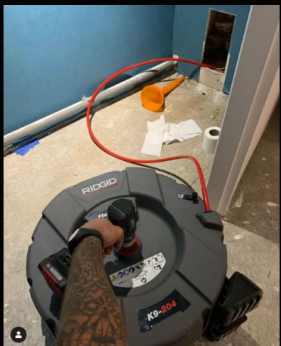
ОЧИСТКА ОТ НАКИПИ
