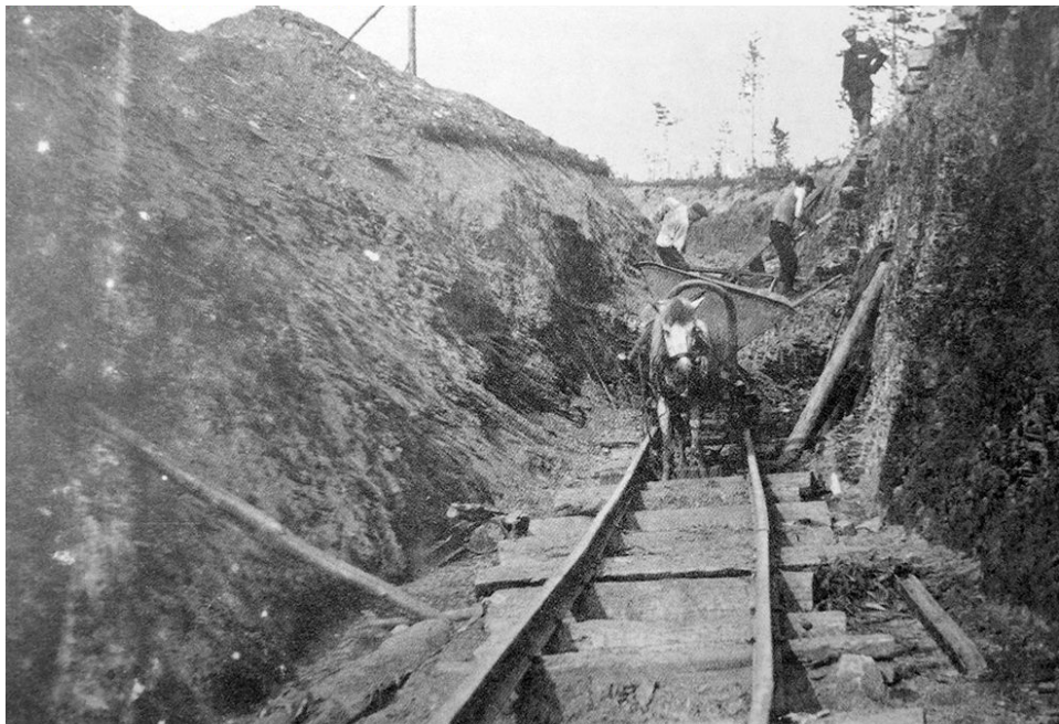
Прокладка разрезной траншеи на Тюленевском никелевом руднике (Челябинская обл. ), 1933г.
