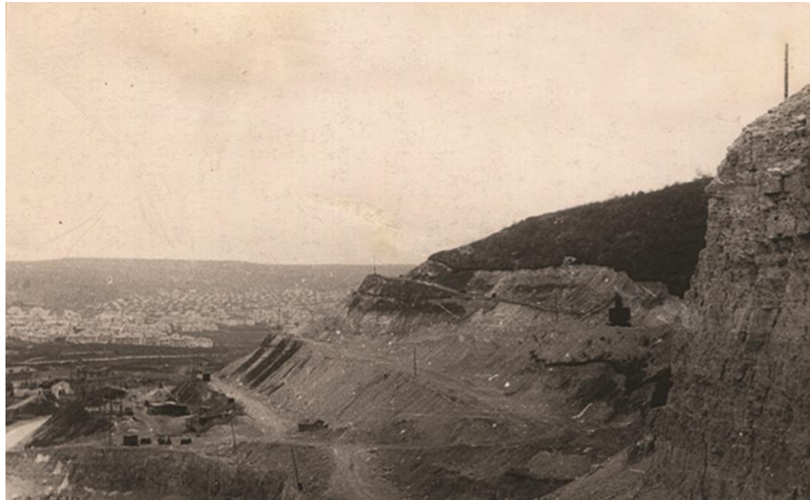
Общий вид вскрытия внешней петлевой полутраншеей месторождения Могучова гора (Самарская обл.)
