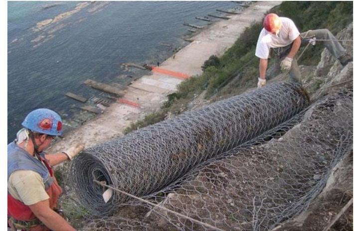
Рисунок 7 – Монтаж сетки СтилGRID
