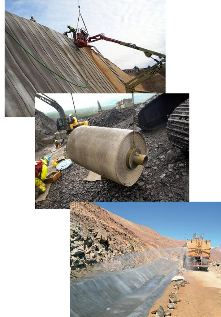
Рисунок 2 – Укладка бетонного полотна
