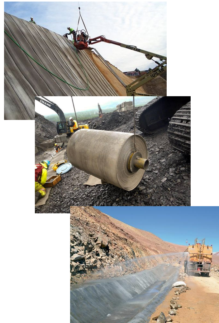
Рисунок 2 – Укладка бетонного полотна
