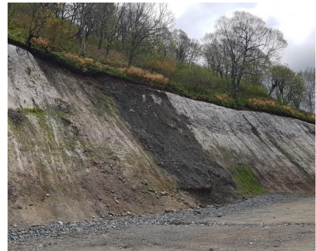
Рисунок 1 – Деформация откоса
