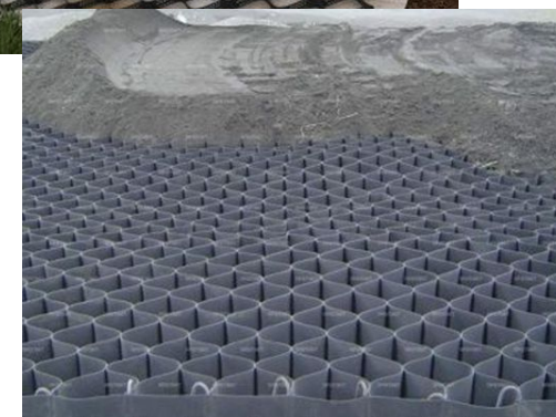
Рисунок 3 – Варианты заполнения: щебнем, песком, бетоном
