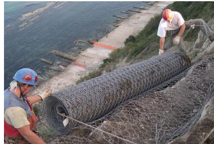
Рисунок 7 – Монтаж сетки Стилгريد
