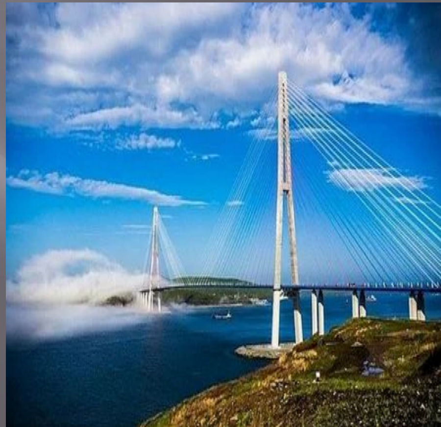
Мост на остров Русский, Владивосток.
