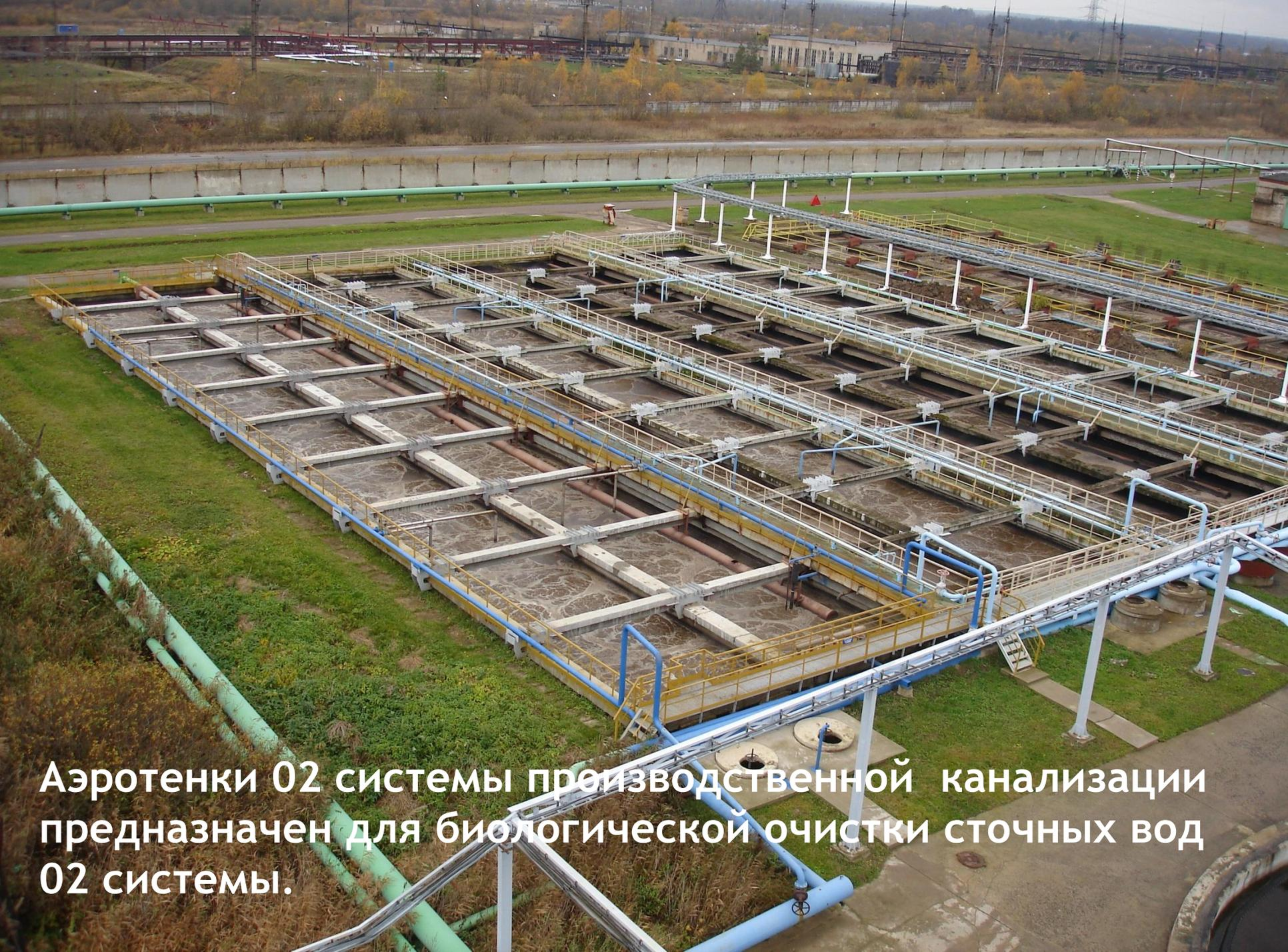
Аэротенки 02 системы производственной канализации предназначен для биологической очистки сточных вод 02 системы.
