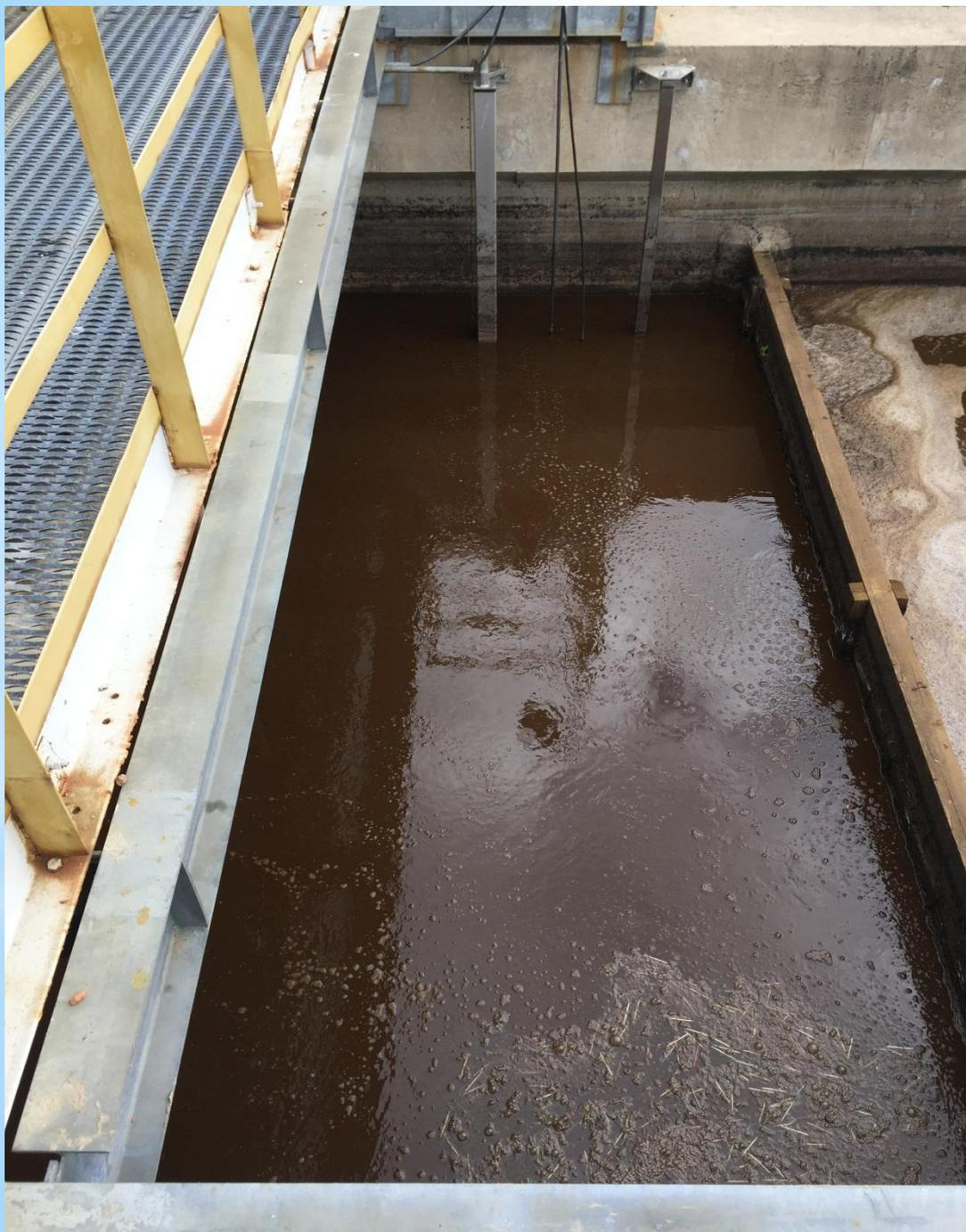
В зоне растворенного кислорода установлена мешалка и погружной осевой насос для организации внутреннего рецикла иловой смеси из зоны растворенного кислорода в аноксидную зону.
