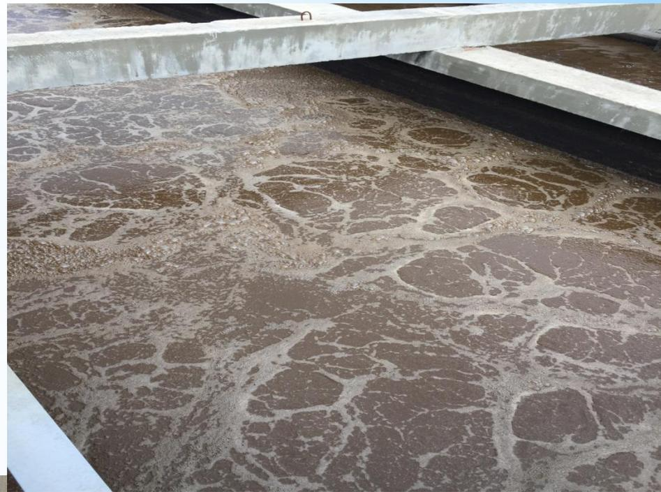
В аэробной зоне аэротенк оборудован системой мелкопузырчатой аэрацией с использованием дисковых аэраторов. Диаметр аэратора-270 мм. Размер образующихся пузырьков 1-3мм.
