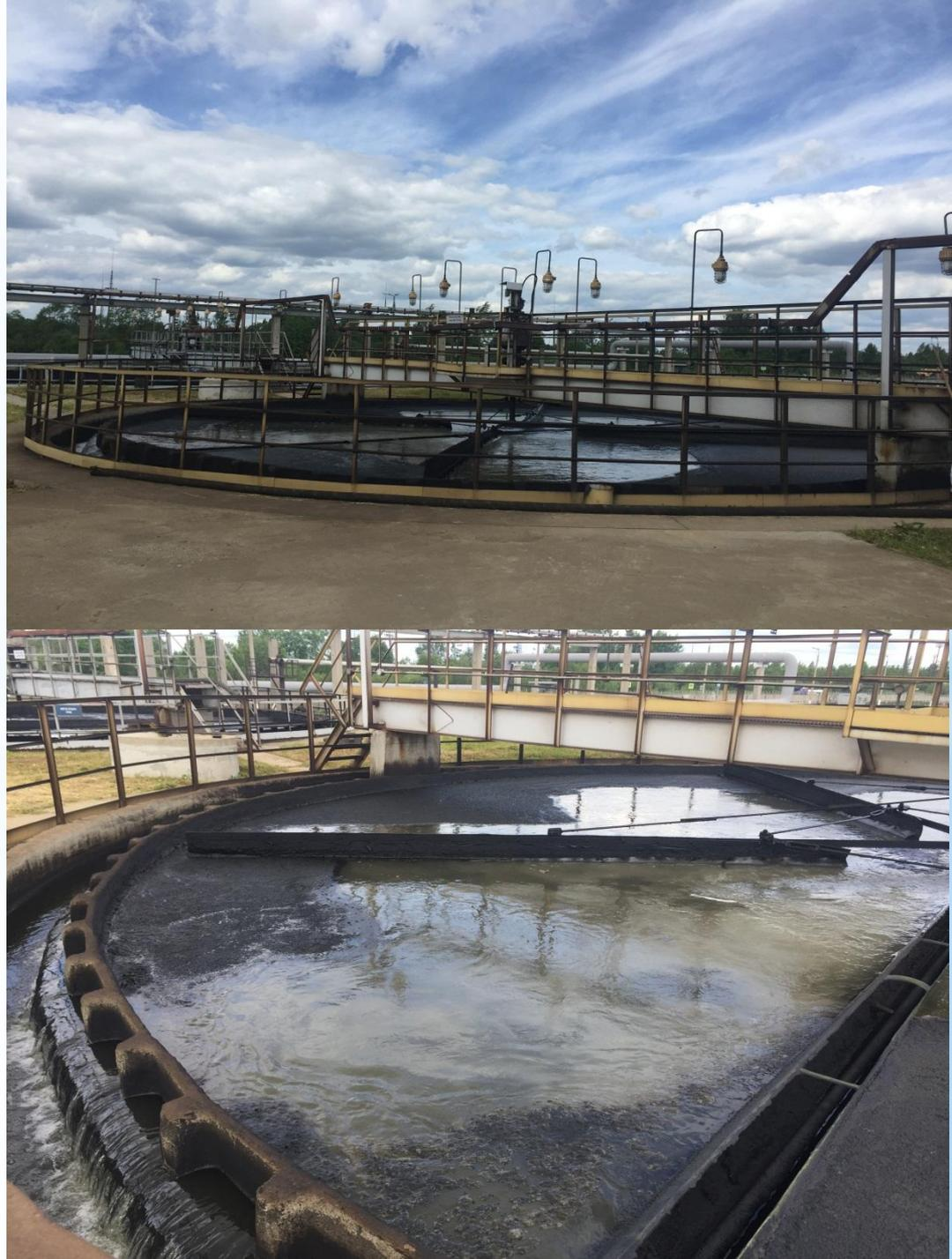
**Биологическая очистка-** предназначена для очистки сточных вод от растворенных органических загрязнений с использованием микроорганизмов.
