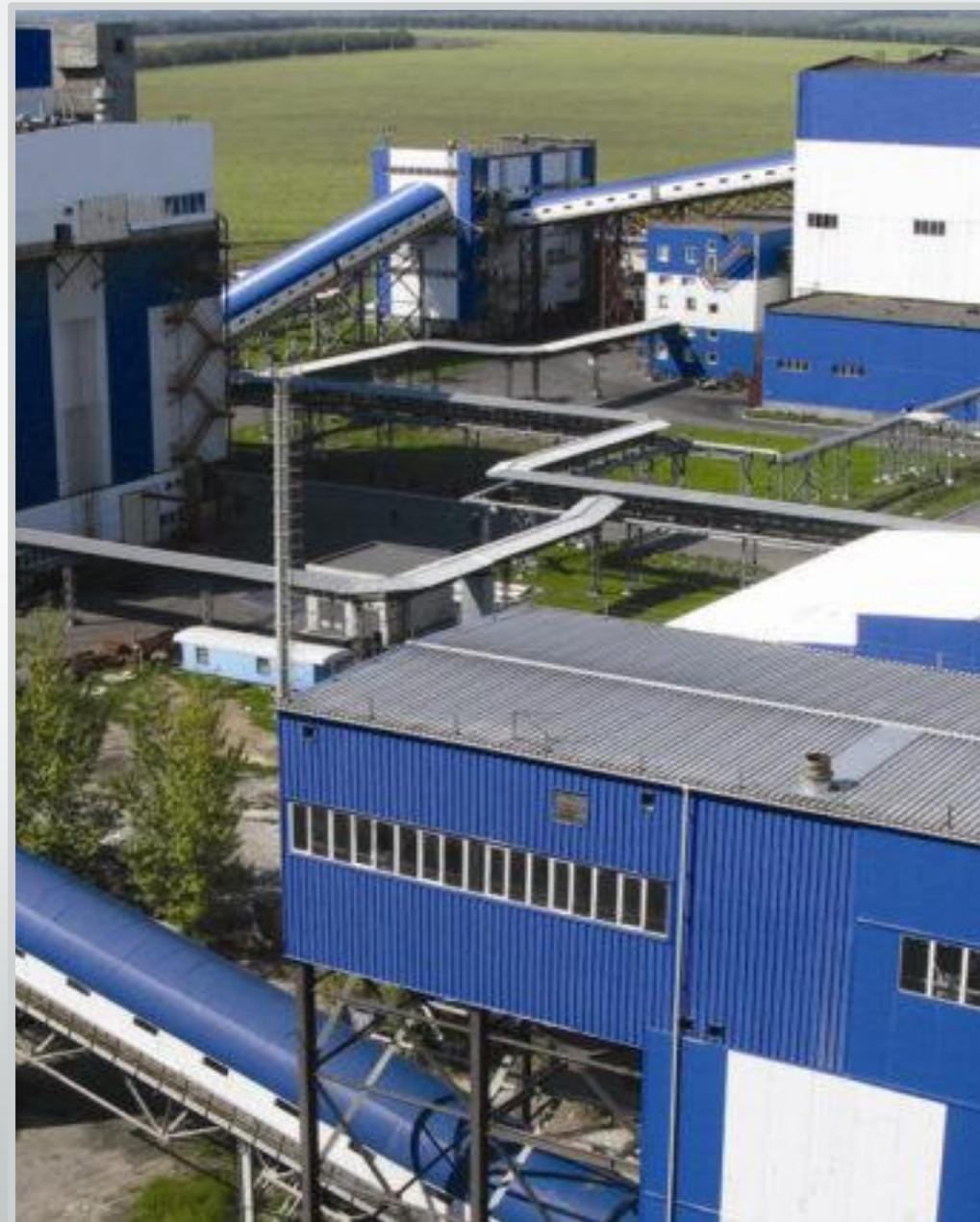
С помощью различных технологий (флотация, магнитная сепарация и других) на обогатительных фабриках из добытой руды получают концентрат, в котором содержание полезного компонента намного выше, чем в исходном сырье
