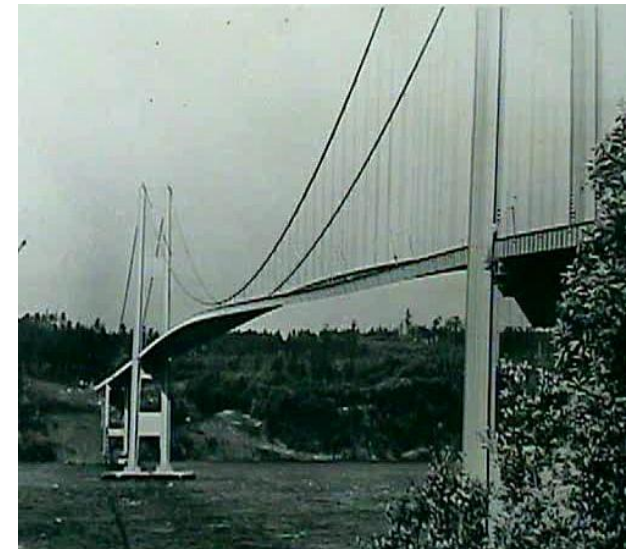
Разрушение моста Такома Нэрроуз
