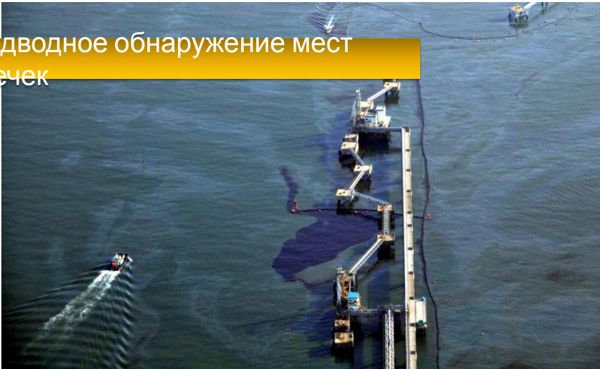
Локализация событий незаконных врезок в трубопровод
