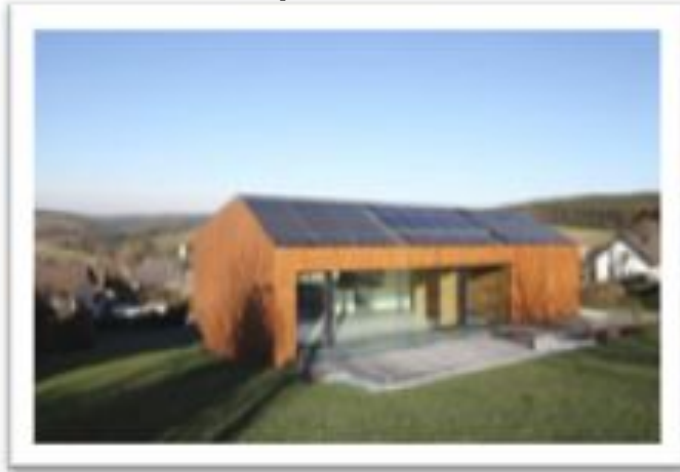
Пассивный энергосберегающий дом в Германии:
