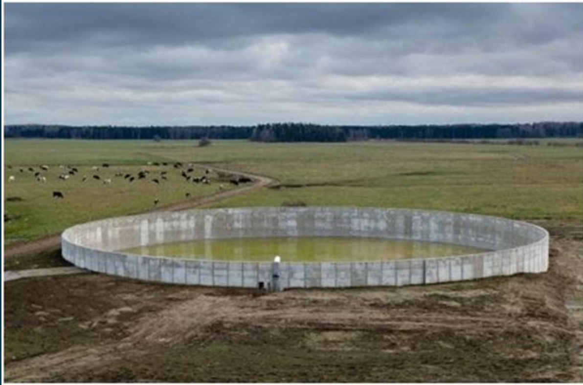
На фото – навозохранилище открытого типа
