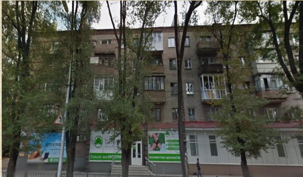
Жилой дом по ул. Университетской в г. Донецке
