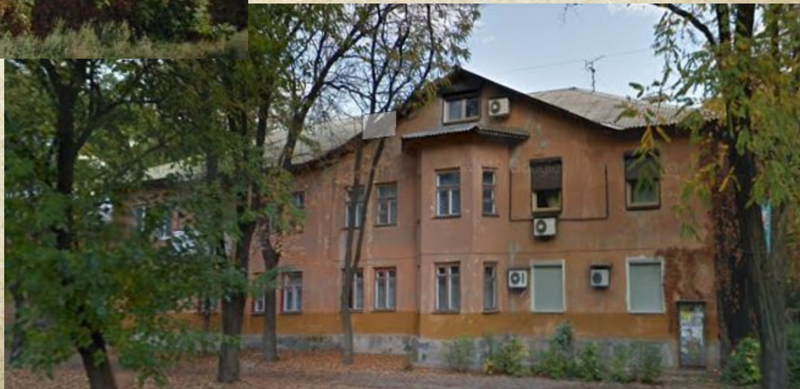
Вверху: жилой дом по ул. Олимпиева в г. Донецке.
