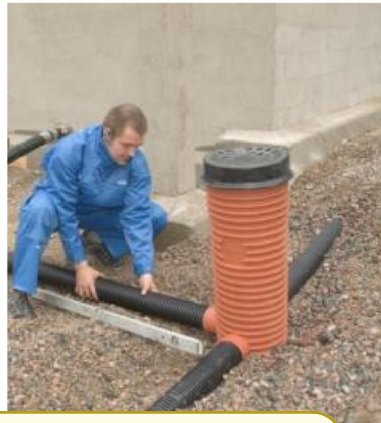
**Система дренажа здания будет эффективно работать при устройстве дренажного колодца на каждом углу здания**
