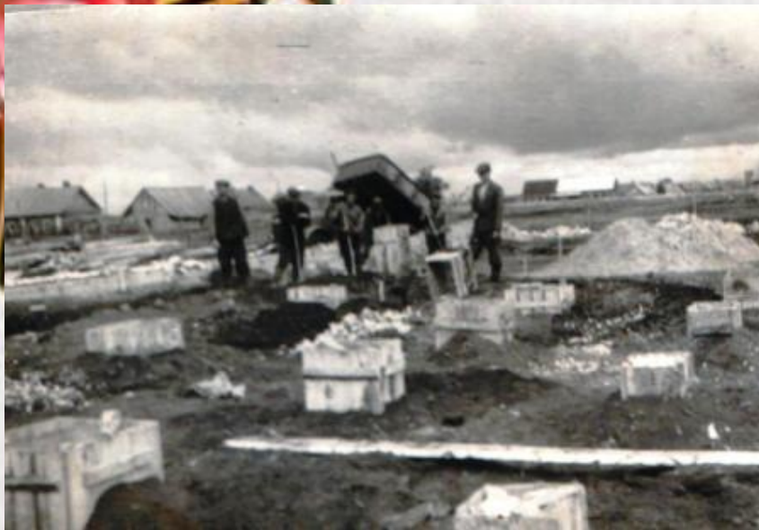
Начало строительства школы
