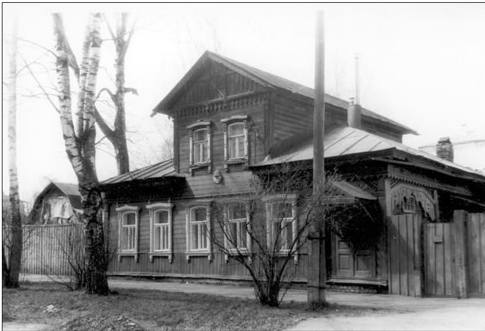
Дом № 30 — образец деревянной жилой застройки Костромы кон. XIX в.
