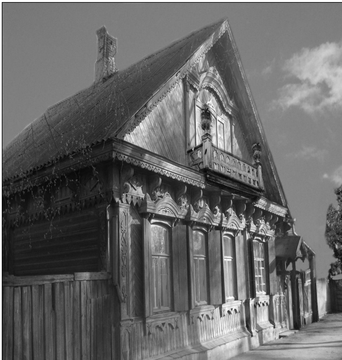
Дом № 22 — образец деревянной жилой застройки Костромы нач. XX в.
