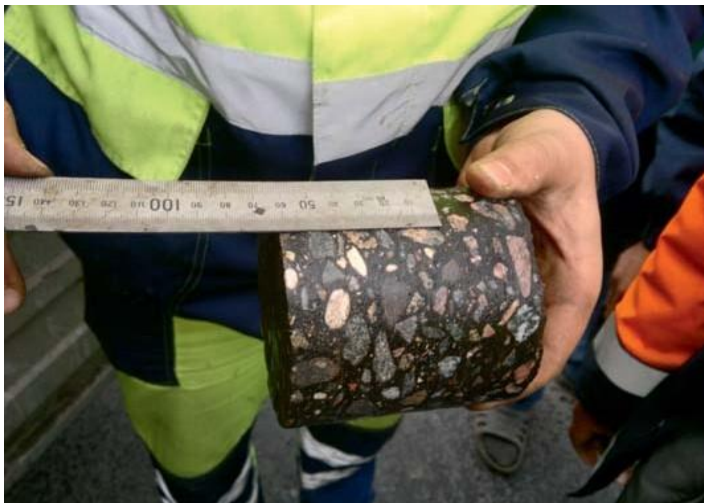
г. Москва, ул. Голубинская. Ремонт асфальтобетонных покрытий
