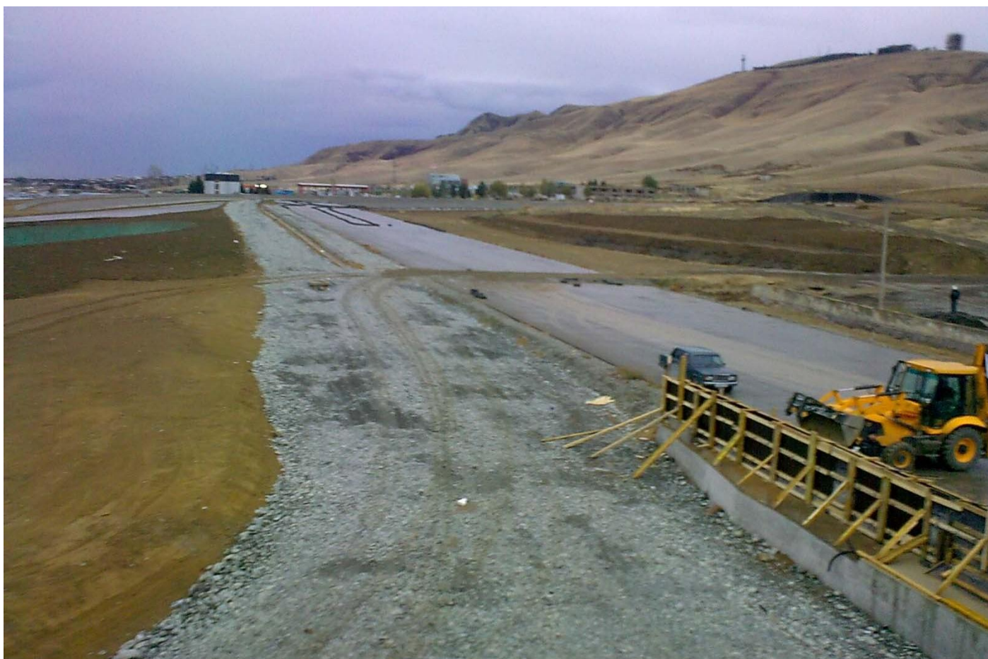
Этап строительства гоночной трассы "РУСТАВИ" в республике Грузии.
