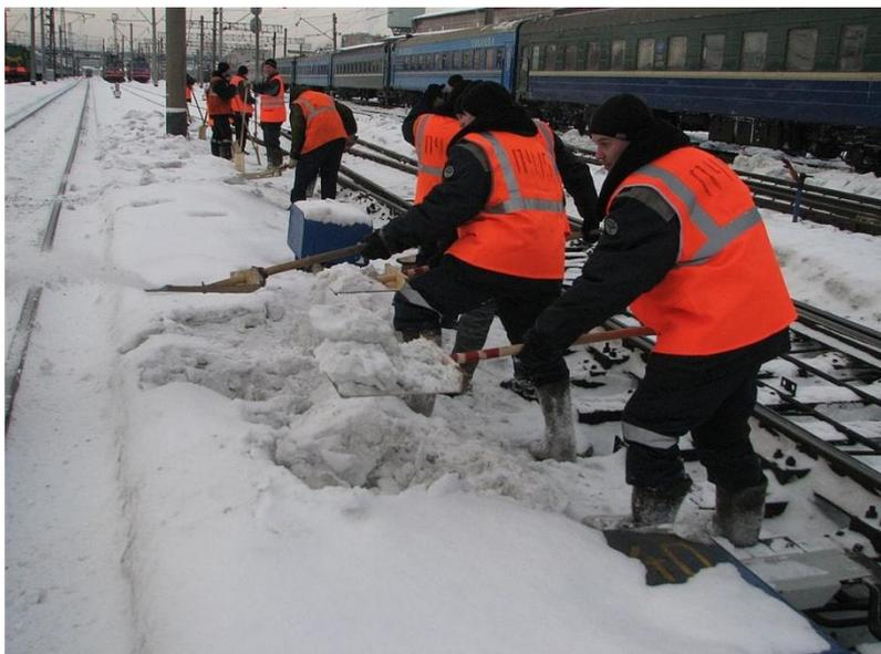
При очистке стрелочных переводов от снега, в первую очередь очищают пространство между рамными рельсами и острьяками стрелок, контррельсовые и крестовинные желоба.
