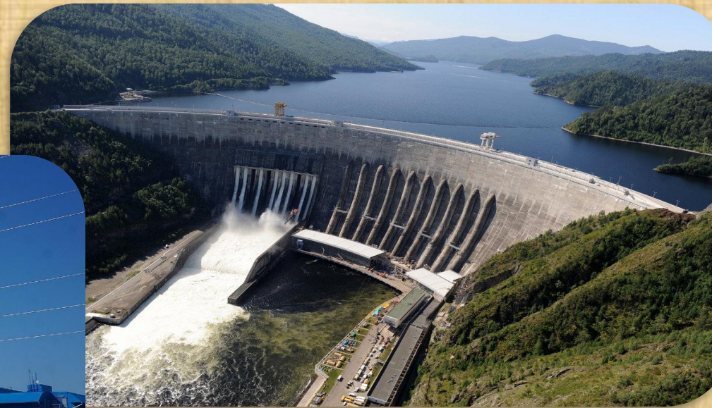
Гидроэлектростанция. Самая крупная называется «Три ущелья» и расположена в Китае.
