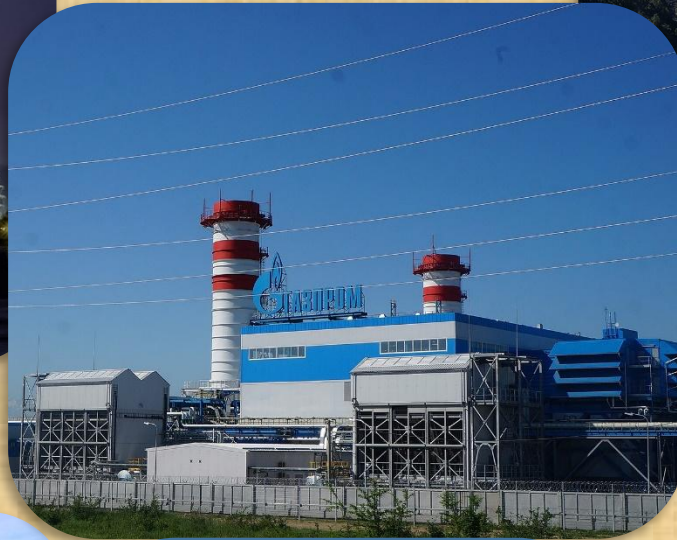
Тепловая электростанция (или тепловая электрическая станция) — электростанция , вырабатывающая электрическую энергию за счёт преобразования химической энергии топлива в процессе сжигания в тепловую
