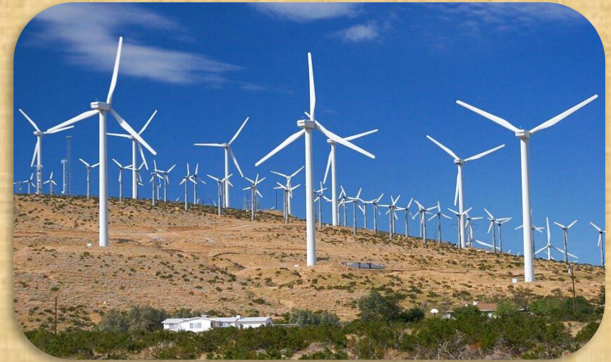
Электростанция которая использует энергию ветра. Самая крупная «Ганьсу» Расположение: город Цзюцюань, провинция Ганьсу, Китай
