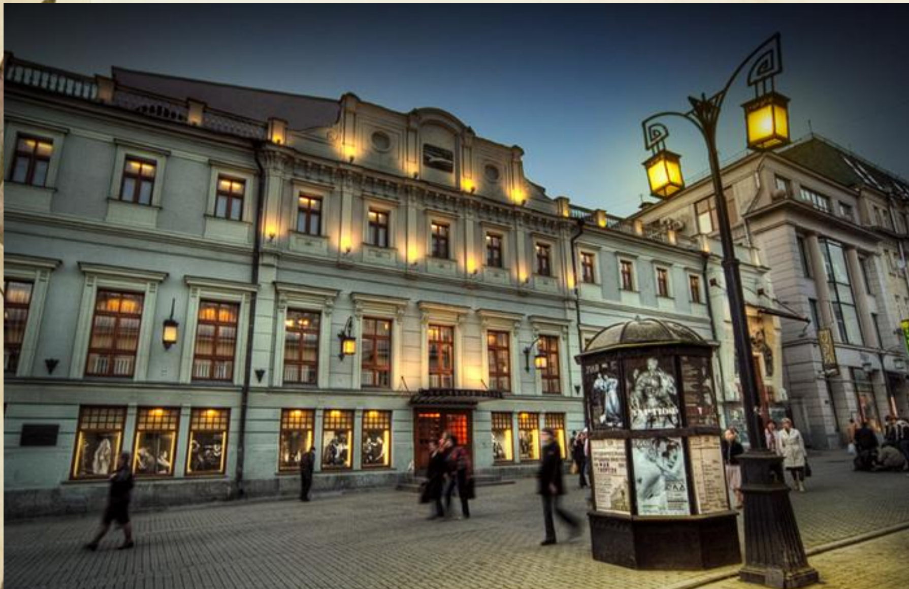
Здание МХТ. Москва. арх. Ф. О. Шехтель
