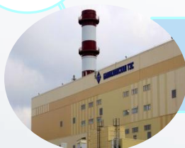
Балаклавская ТЭС в г. г. Севастополе
