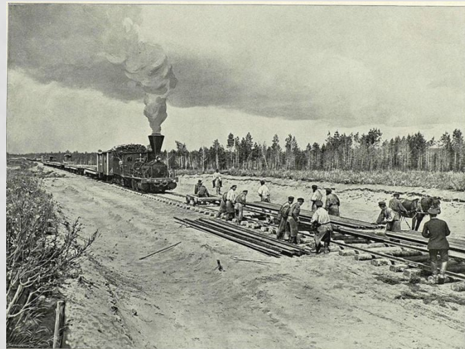
Укладка пути. Альбом "Великий путь. Виды Сибири и Великой сибирской железной дороги" 1899
