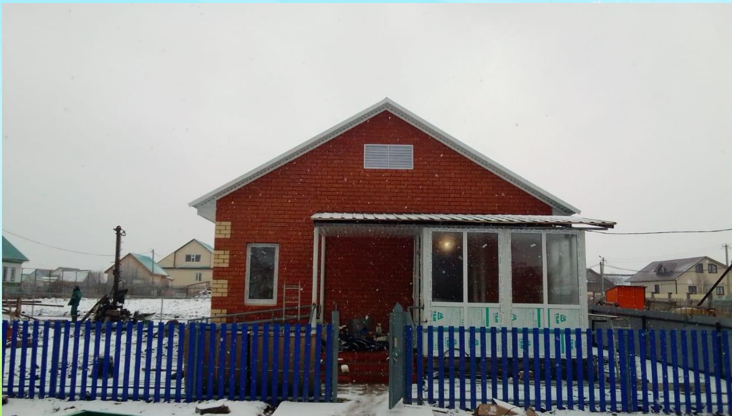
Строительство нового ФАПа на стадии завершения
