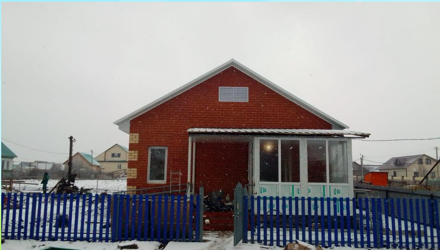
Строительство нового ФАПа на стадии завершения
