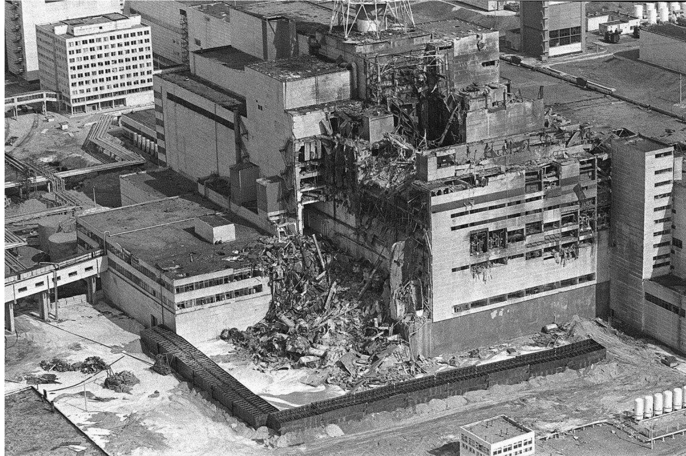
Взрывы привели к полному разрушению реактора и его активной зоны, систем охлаждения, а также здания реакторного зала.
