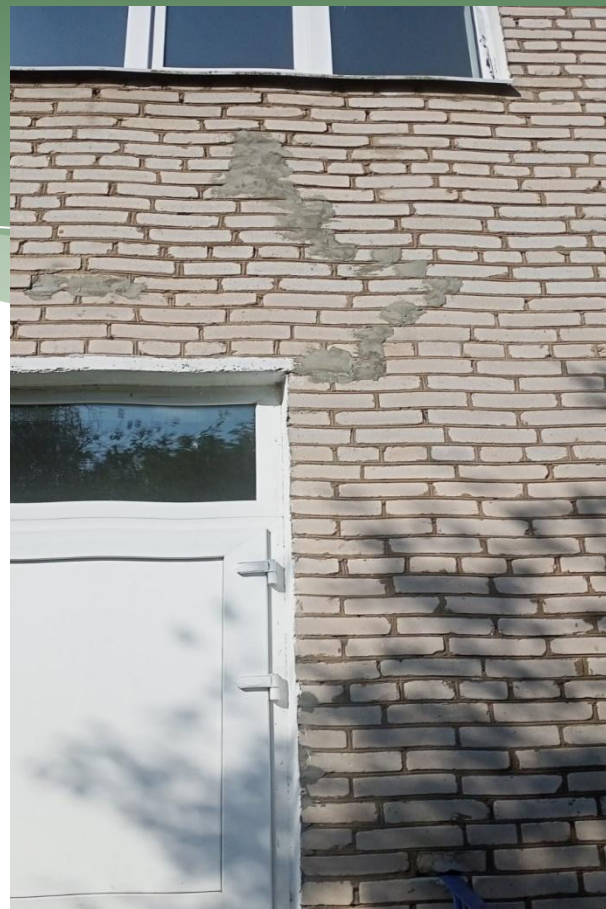
Устранение нитевидной трещины между первым и вторым этажами
