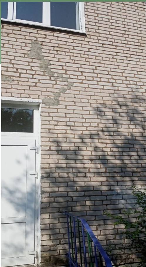
Устранение нитевидной трещины между первым и вторым этажами
