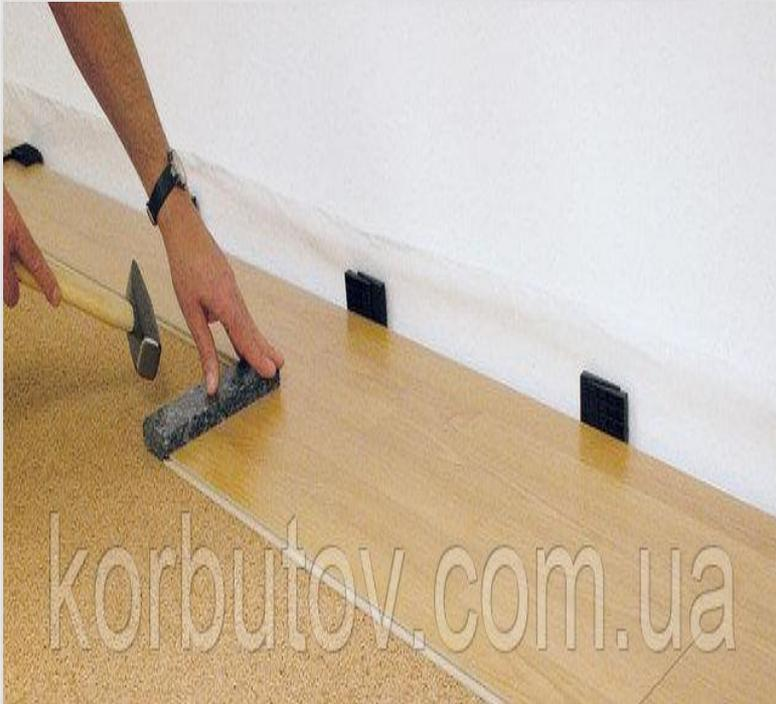
Еще одна эксклюзивная новинка в сфере отделки помещений - бесклеевой пол, так называемый "ламинат на замках". Обладая всеми перечисленными выше достоинствами, он действительно не требует применения клея при сборке.
