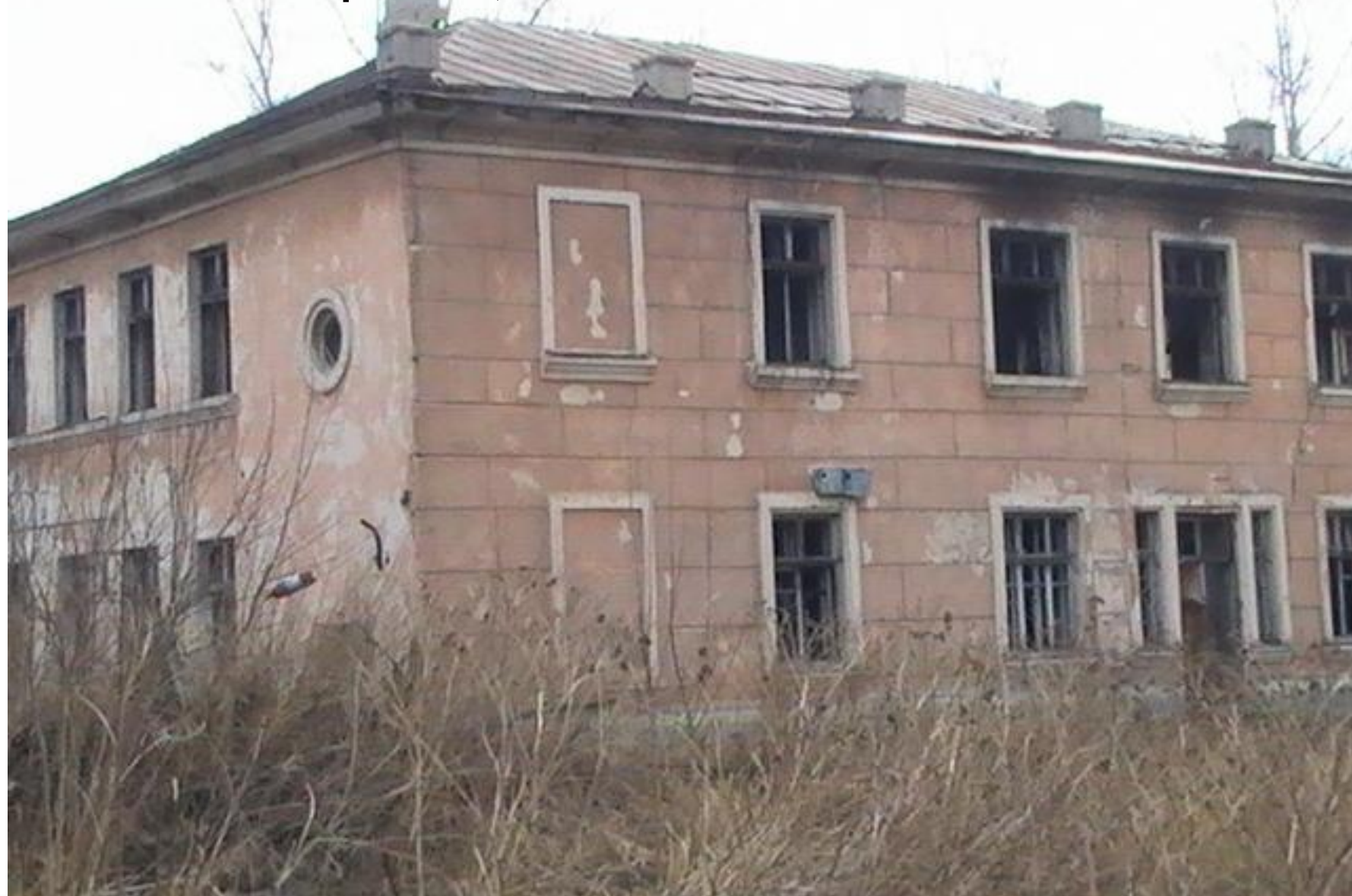
Пустующее здание, рядом с Успенской церковью, бывший детский сад
