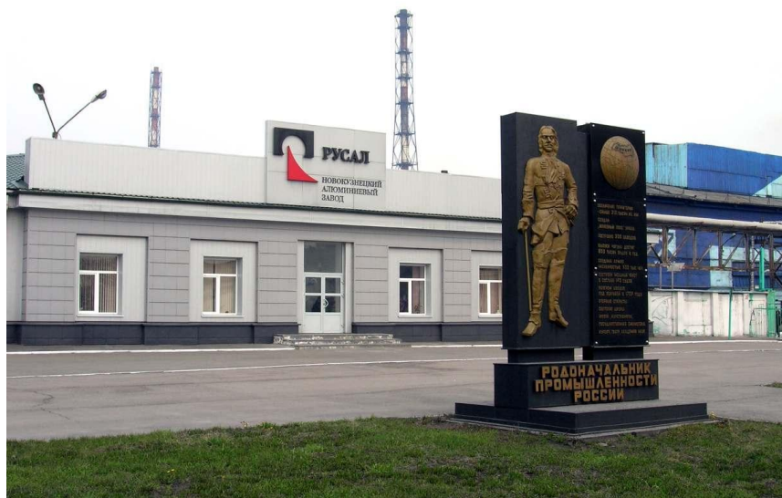
Новокузнецкий алюминиевый завод
