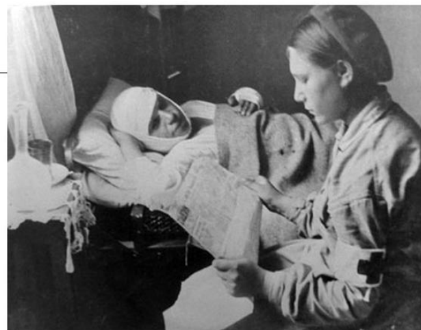
В госпитале на дежурстве. Краснодар, 1943 г.
