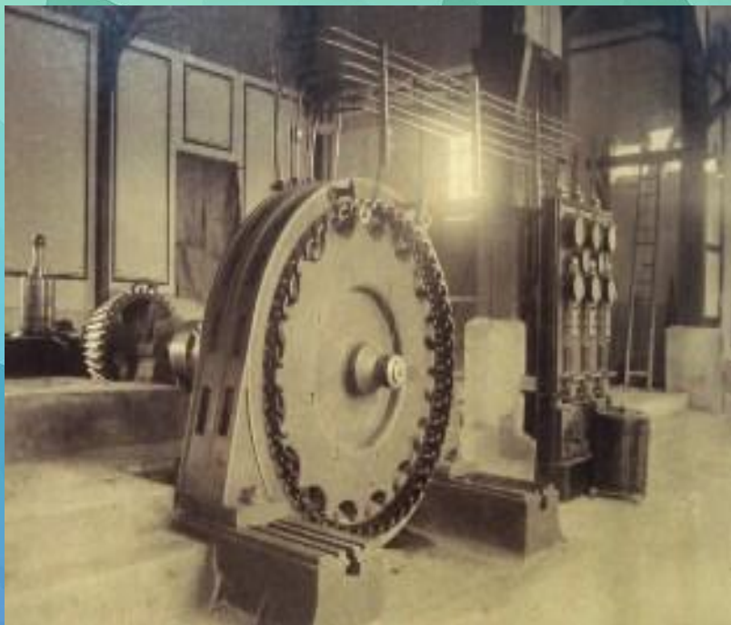
Трёхфазный генератор в Лауффен-на-Неккаре (Баден-Вюртемберг) - 1881 год.
