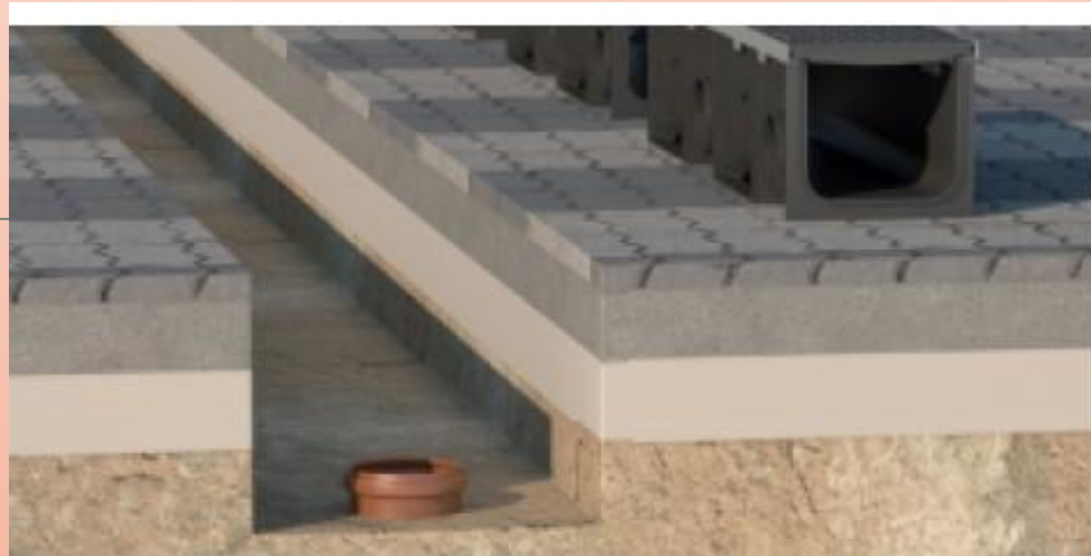
1. Подготовка основания и подключение трубы
