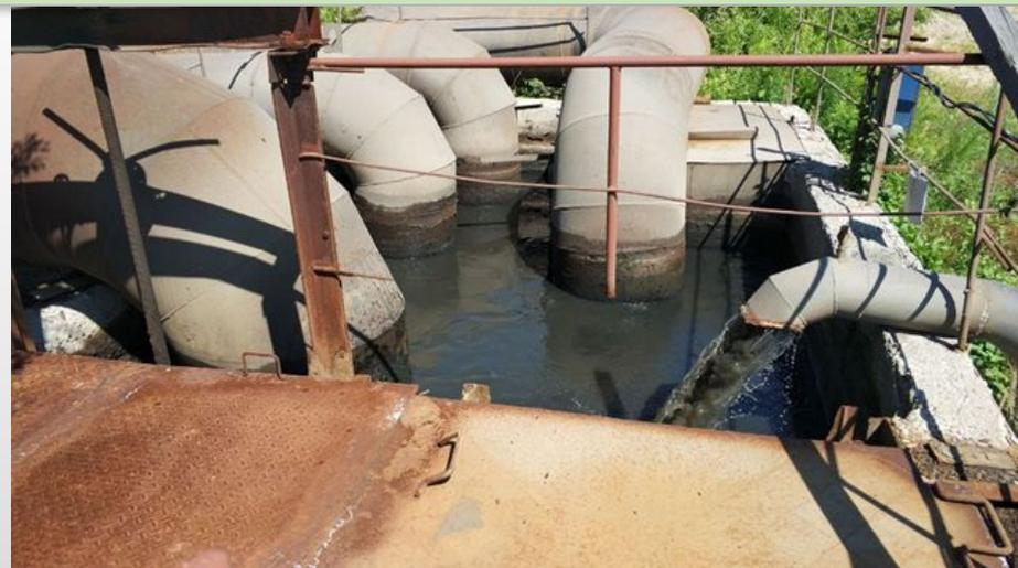
СТОЧНАЯ ВОДА ИЗ СИСТЕМЫ КАНАЛИЗАЦИИ ПОСТУПАЕТ В ПРИЕМНУЮ КАМЕРУ, А ЗАТЕМ ПРОХОДИТ ОЧИСТКУ НА СПЕЦИАЛЬНЫХ СООРУЖЕНИЯХ.
