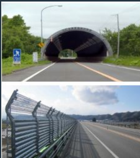
Снегозащитная галерея и ограждение
