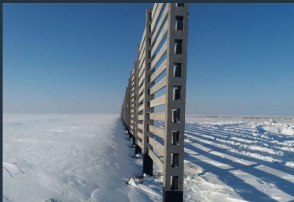
Железобетонное и ограждение
