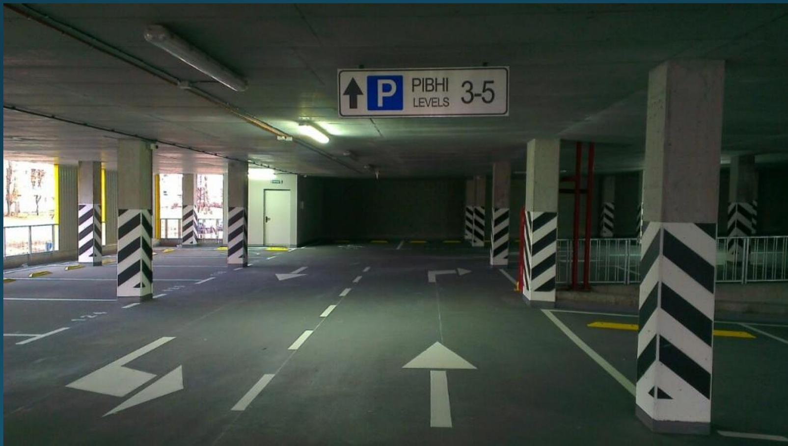
**2.1.1 — 2.1.3.** — обозначают элементы дорожных сооружений (опор мостов, путепроводов, торцовых частей парапетов и тому подобного), когда эти элементы представляют опасность для движущихся транспортных средств
