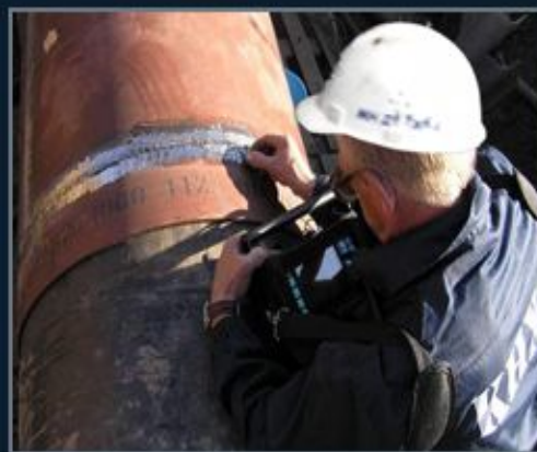
сварка и контроль
