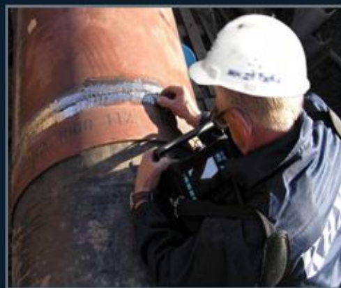
сварка и контроль
