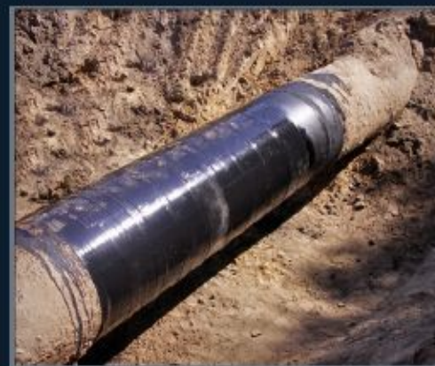
нанесение изоляции
