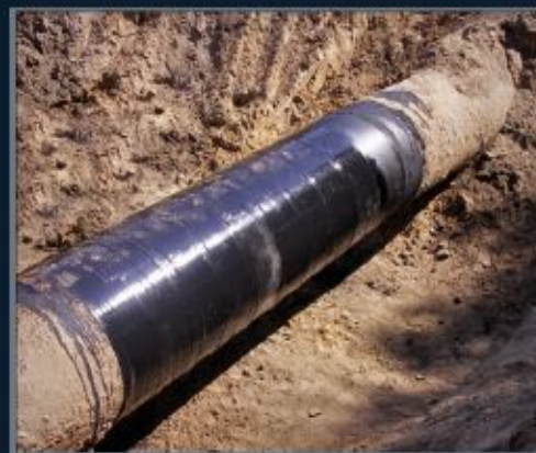
нанесение изоляции
