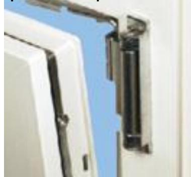
противовзломный зацеп в районе кронштейна
