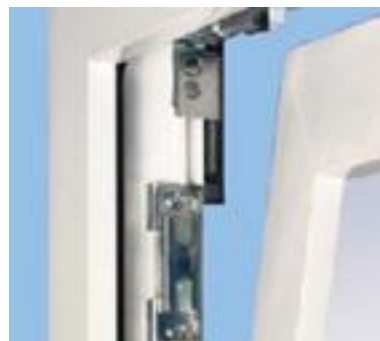
противовзломный зацеп в районе кронштейна
