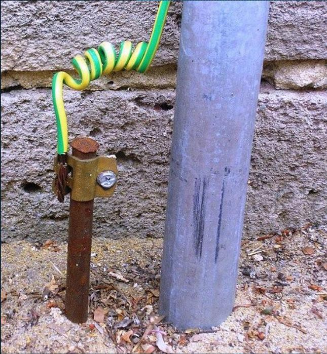
Заземлитель (металлический стержень) с присоединённым заземляющим проводником
