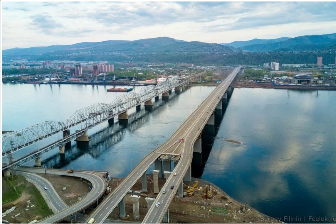
Общий вес смонтированных металлоконструкций пролётных строений мостового перехода составляет 26 177,9 тонны, объём — 328,72 кубометра железобетонных пролётных строений. Объём железобетонных плит проезжей части — 7 658 кубометров
