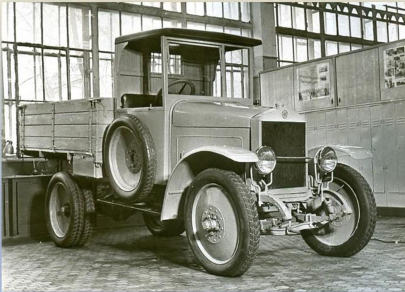
В ноябре 1924 в России начали выпуск автомобиля марки «AMO-Ф-15» (Автомобильное Московское общество. Он имел редкие для того времени электрические фары, пневматические шины, штампованные дисковые колеса.
