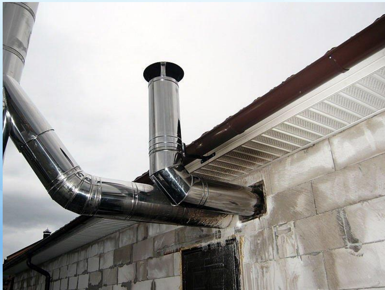
низкая дымовая труба
