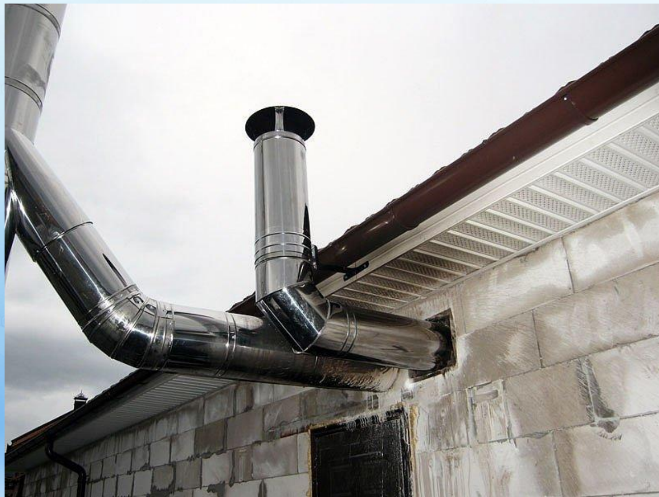
низкая дымовая труба
