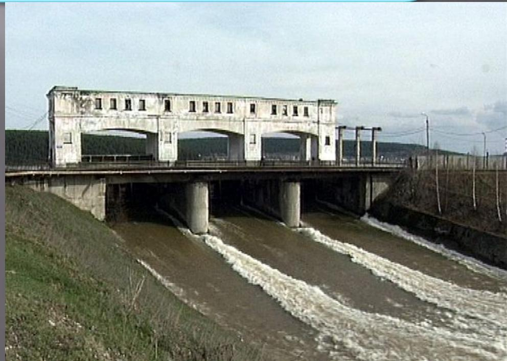
**Водозаборное сооружение.** Это гидротехническое сооружение для забора воды из источника питания (реки, озера, подземного источника) с целью использования ее для нужд гидроэнергетики, водоснабжения или орошения полей.
