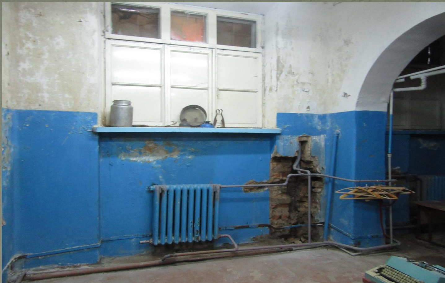
Цокольный этаж (до ремонта)
