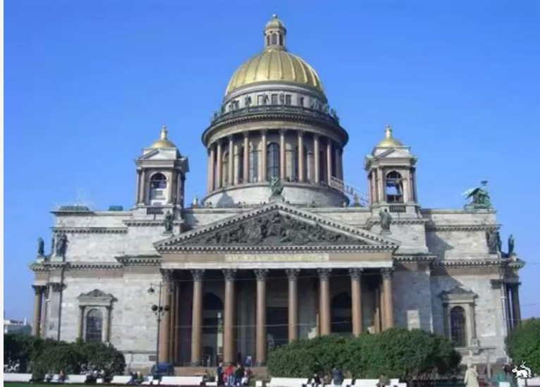
Исаакиевский собор в Санкт-Петербурге
